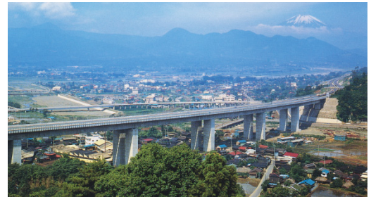
写真-1 完成当時の全景
