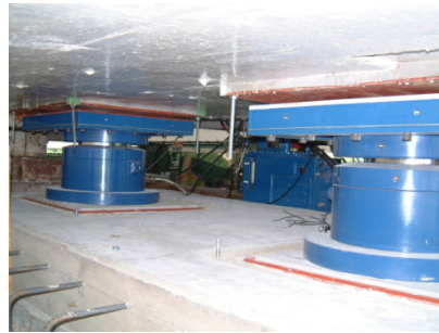
ジャッキによる仮受け
