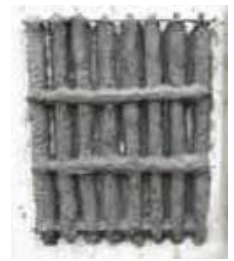
(b) 防錆モルタル塗布
