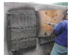
(c) 吹付け施工状況
