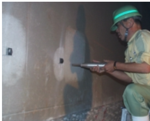
写真 - 2 テストハンマー試験状況
