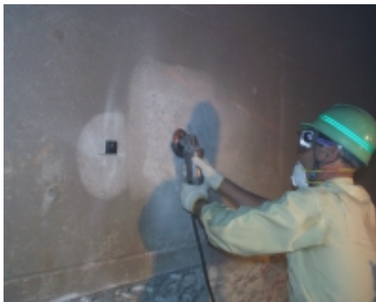
写真 - 1 コンクリートの切削状況
