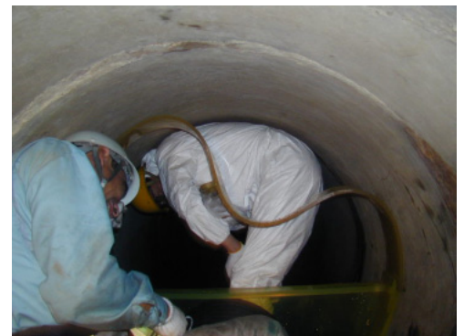
写真－1 固定バンドの設置
