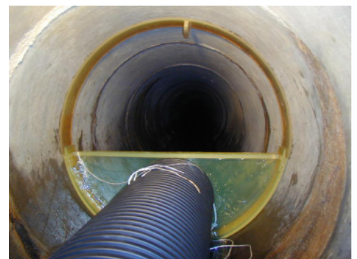
写真－2 設置完了
