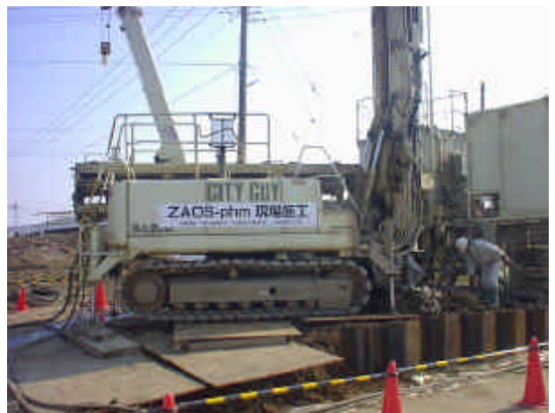
写真2 ハイブリッドパイルの施工
