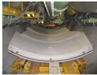
写真－４ セグメント供給装置
