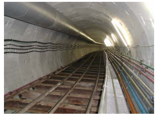
写真－７ 曲線部坑内仕上り状況（WBセグメント）
