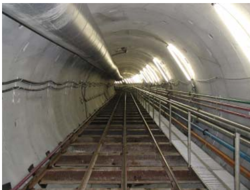
写真－６ 直線部坑内仕上り状況（QBセグメント）
