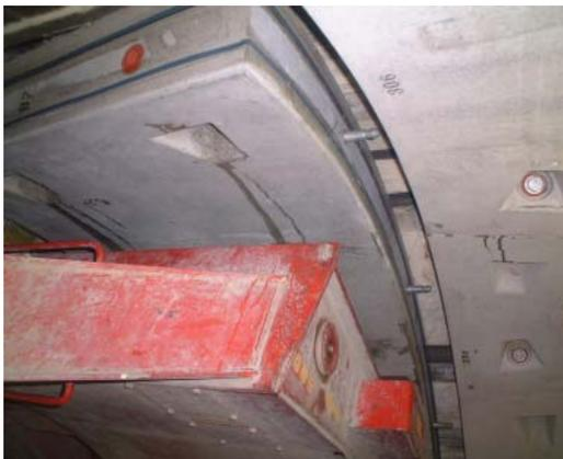
写真-2 CBセグメント施工状況
