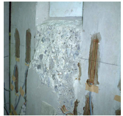
写-2 ロック部破壊状況
