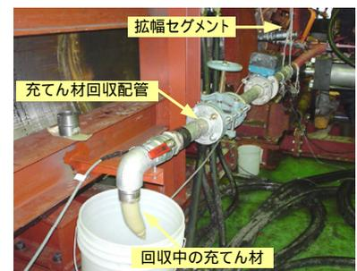
写真3 沈下抑止充てん材回収状況
