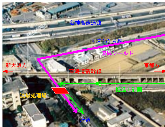
図1 処理場投入点付近の概観
