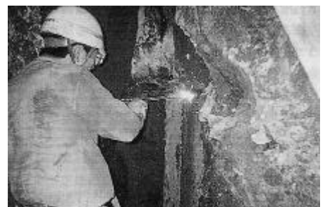
写真-2 ガス切断状況
