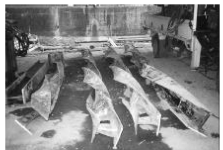
写真-1 地上から引抜いた支障杭
