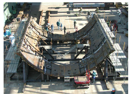
写真 - 2 補強鋼版仮組み状況
