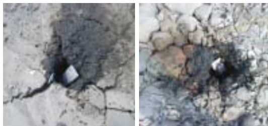
固化地盤 泥岩密詰め粘土地盤 写真-6 打設完了状況
