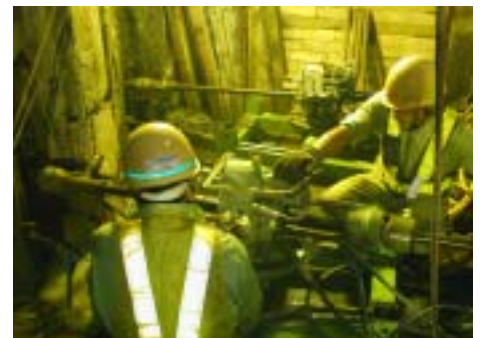
水平止水注入（写真 - 3）
