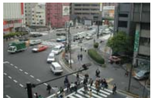
工事箇所全景(写真-1)
