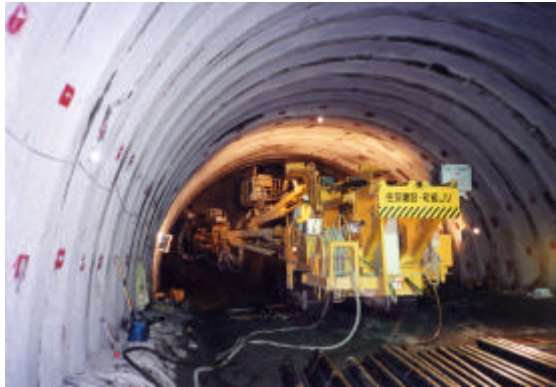
図-4 AGF工施工状況(D -c)
