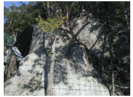
写真-5 ロープネット工+吹付モルタル
