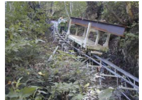
写真-3 H型鋼運搬状況
