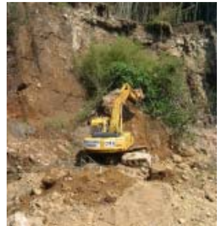
写真-2 遠隔操縦ロボットを装着したバックホウによる緊急災害復旧作業(大分県別府市朝見川)
