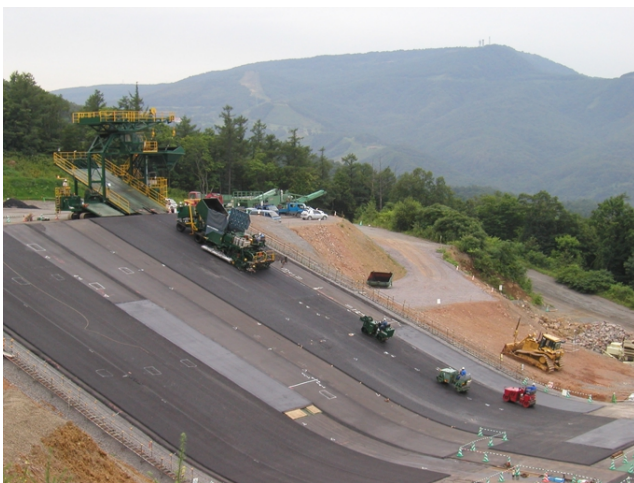
写真 - 1 斜面部舗設試験全景
