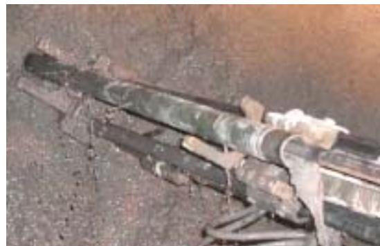
写真-2 開発品（FWタイプ）削孔状況
