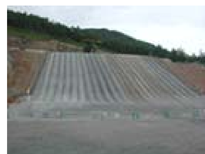
写真-1 斜面部舗設試験ヤードの全景
