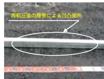
写真-3 再転圧後の舗設表面
