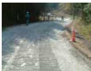
写真－1 粉体散布状況
