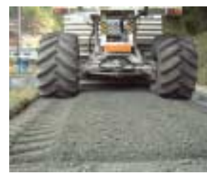
写真－2 再生路盤工施工状況
