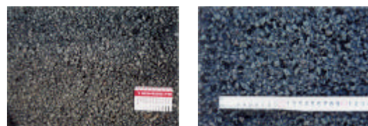
17%排水性舗装表面(表面処理) [左: 降雨時]
