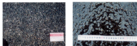
17%排水性舗装表面 [左: 降雨時]
