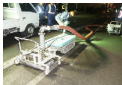
写真-1 表面処理状況
