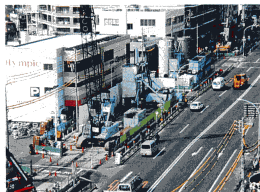
写真-1 TRD 工法施工状況
