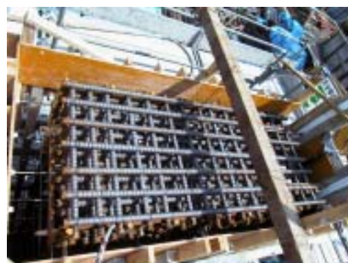
写真 - 1 配筋状況
