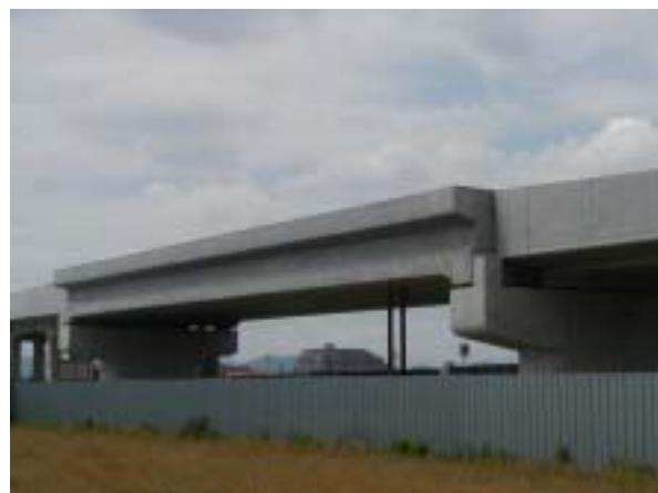
写真3 PC 下路桁完成写真
