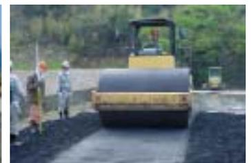
写真-2 締固め状況
