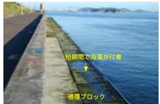
写真2 護岸補強工事の完成状況
