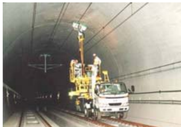
図 3：現場トンネル試験状況
