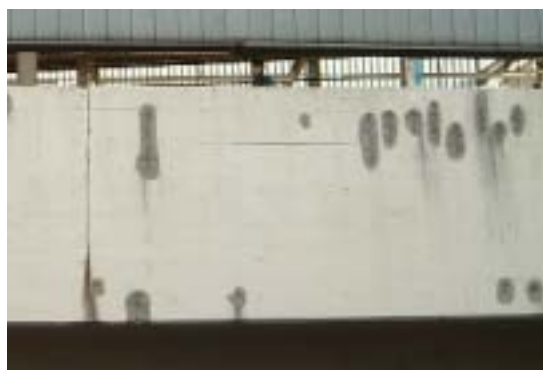
写真5 はつり落とし後（上り線，小田原方）
