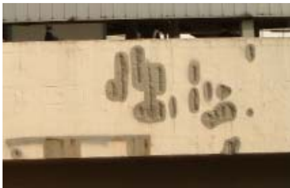
写真4 はつり落とし後（上り線，新宿方）
