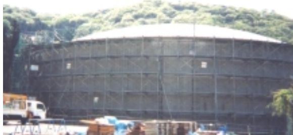
写真-1 建設中の PC タンク
