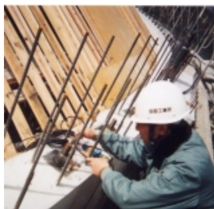
写真-2 弾性波入力状況
