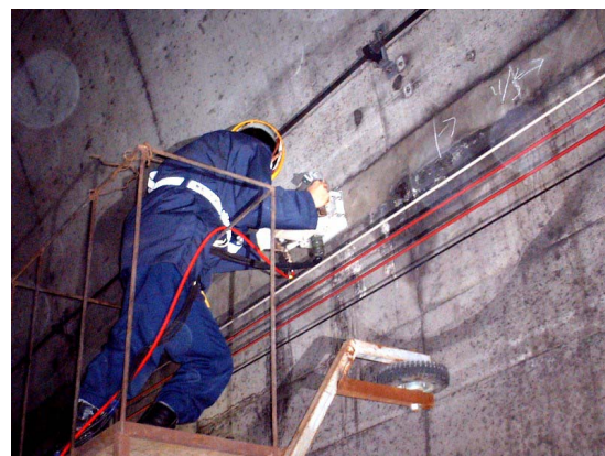
写真-2 探査装置を用いた検査状況
