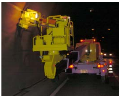
写真-2 Oトンネル側壁部点検状況
