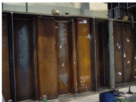
写真-2 破壊状況 (No3 試験体)
