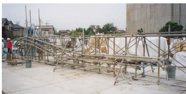
写真-1 試験体全景
