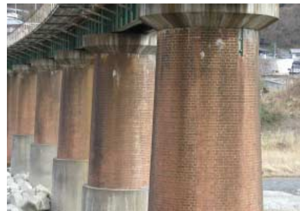
図-1 レンガ積み橋脚
