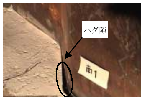
図-3 接合部のハダ隙現象
