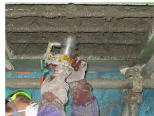
図2 吹付け実施状況
