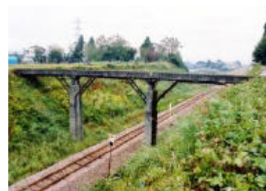
写真－1 補修前の水路橋
