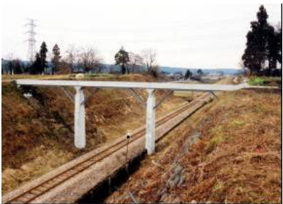
写真ー２ 補修後の水路橋
