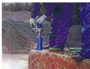
写真 - 2 コア抜き状況
