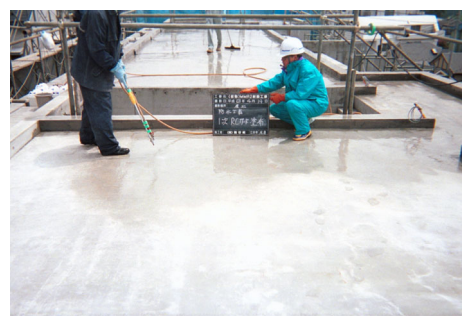
写真-1 屋上床面への塗布状況
