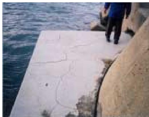
写真-1 無筋基礎の劣化状況
