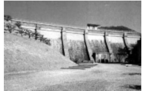
写真 - 1 本庄水源地堰堤
