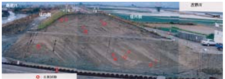
図-1 堤防の開削断面全景
