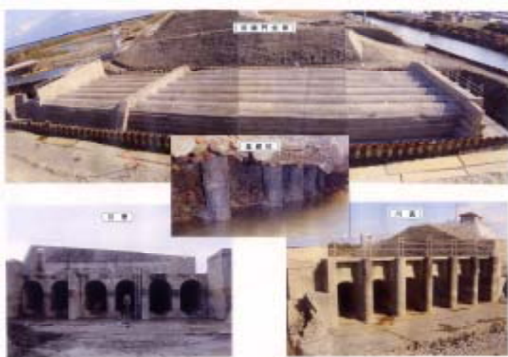
図-4 樋門開削状況
