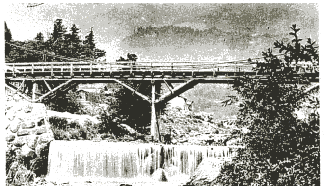
写真-5 長野の和合橋
