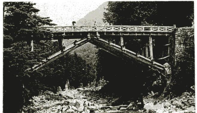
写真-1 長野の風嵐の橋
