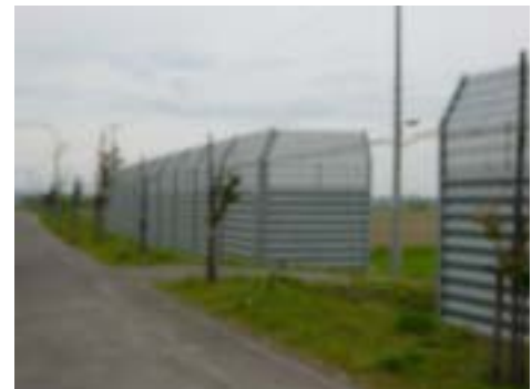
写真 1 副防雪柵の設置状況(生振)
