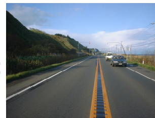
図-2 ランブルストリップスの規格 写真-1 ランブルストリップスの設置状況
