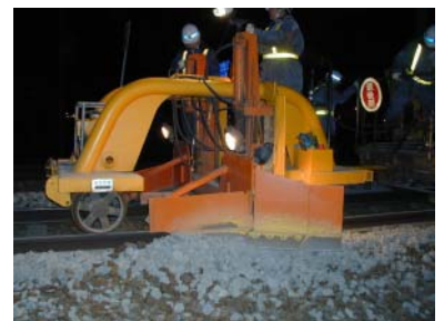
【掻き均し機による作業】
