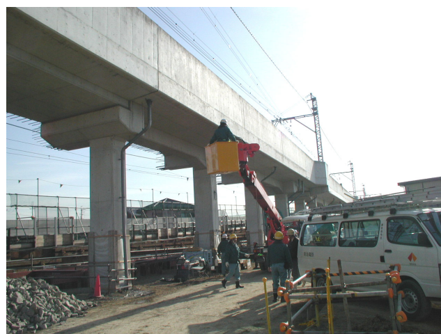
写真-1 衝撃振動試験実施状況
