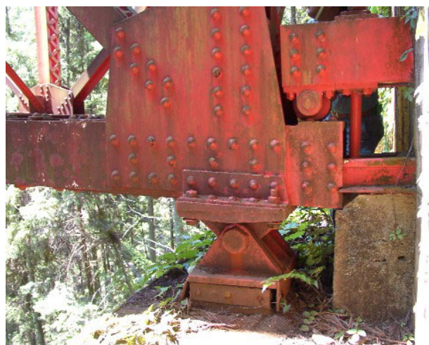
写真-1 側径間端部支承部補修前の状況
