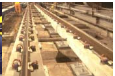
図-6 ラダー枕木敷設状況写真
