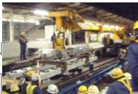
図-5 ラダー枕木敷設状況写真
