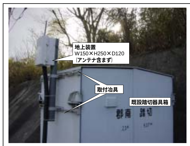
図－3 地上装置取付け状況
